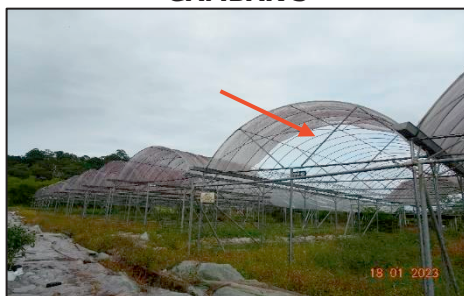
TKPM Batang Merbau, Tanah Merah - Kerosakan SPH di Lot Tanaman (18.01.2023) (Sumber: Jabatan Audit Negara)
