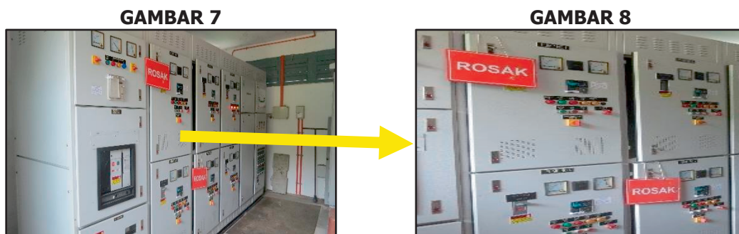
Rumah Pam Bukit Sena - Panel Bagi Dua Pam yang Rosak (06.07.2022) (Sumber: Jabatan Audit Negara)
