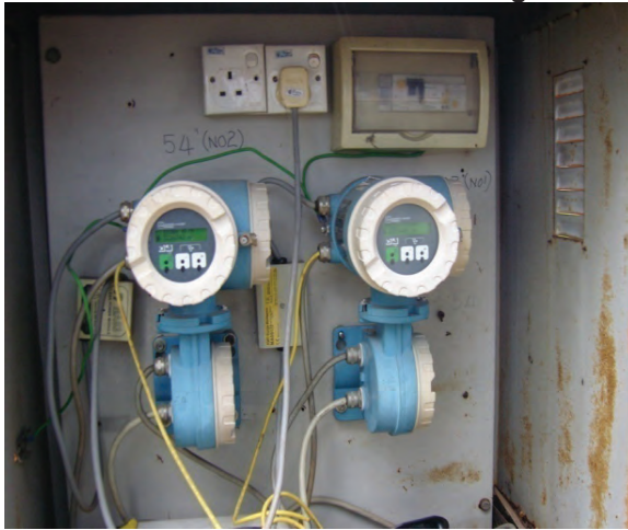
Foto 8.3 Meter Pengeluaran Dari LRA Sungai Dua
