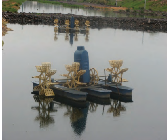
Foto 7.15 Aerator Di Tapak Pelupusan Tidak Berfungsi
