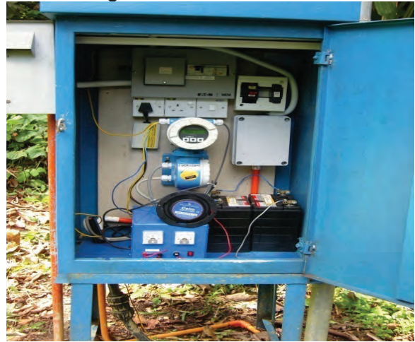
Foto 8.3 Meter Pengeluaran Dari LRA Sungai Dua
