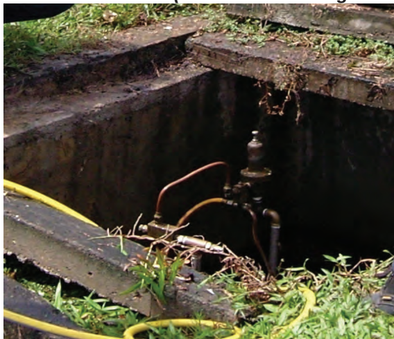
Foto 8.7 PRV (Pressure Reducing Valve) Tidak Berfungsi Di Taman Ilmu
