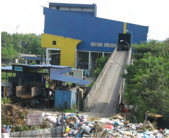
Foto 7.7 Longgokan Sisa Pepejal Di Stesen Pemindahan
