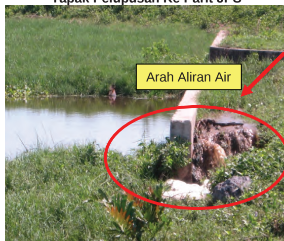
Foto 7.11 Air Kurasan Mengalir Keluar Dari Tapak Pelupusan Ke Parit JPS
