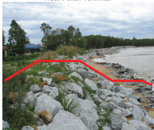
Foto 3.20 Lapis Lindung Yang Mengikut Reka Bentuk Asal Pelan Teknikal
