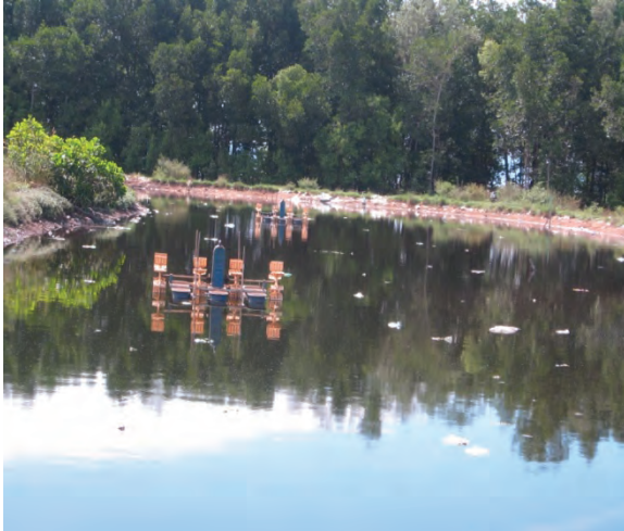
Foto 7.14 Aerator Di Tapak Pelupusan Tidak Berfungsi
