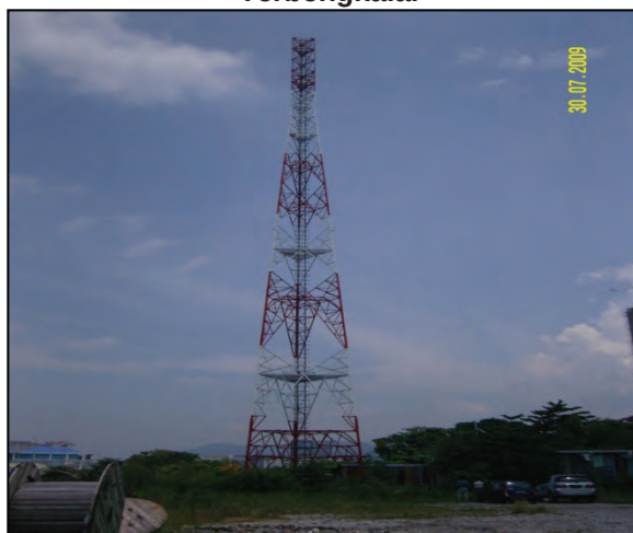
Foto 11.5 Keadaan Menara Telekomunikasi Di Jelutong Expressway Dengan Kos RM0.24 Juta Terbengkalai
