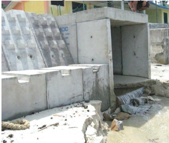
Foto 3.26 Pemasangan Culvert Yang Siap
