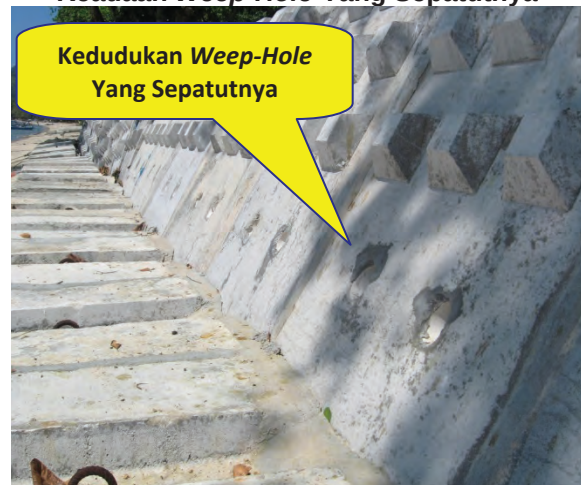
Foto 3.2 Kedudukan Weep-Hole Yang Sepatutnya
