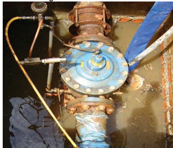
Foto 8.7 PRV (Pressure Reducing Valve) Tidak Berfungsi Di Taman Ilmu
