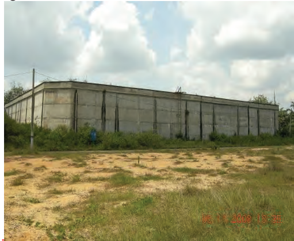
Foto 8.6 Kebocoran Di Dinding Kolam Air Jawi
