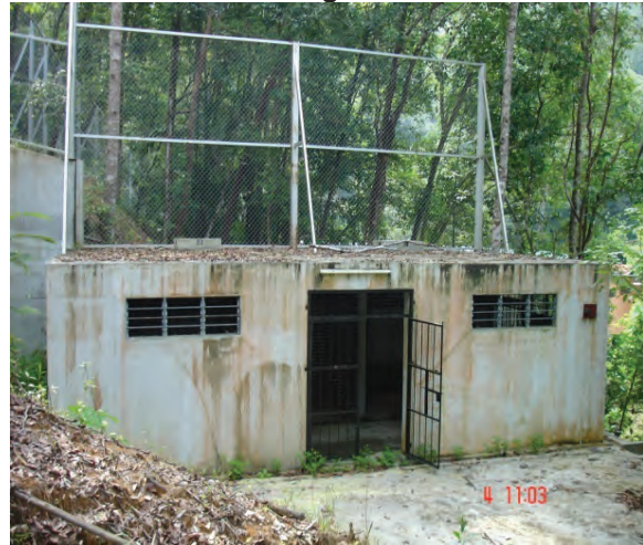
Foto 2.2 Kandang Harimau Yang Terbiar Dan Tidak Digunakan
