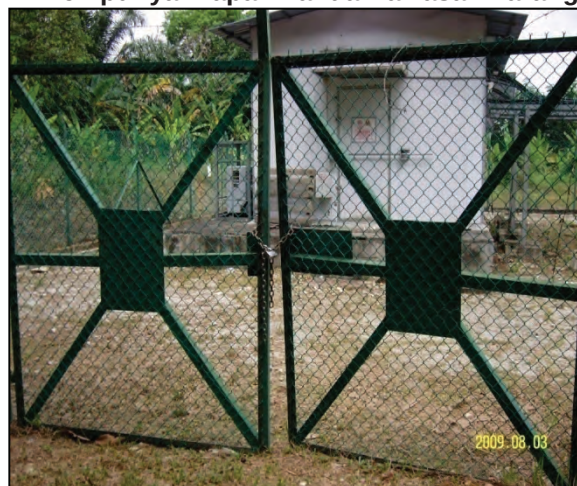
Foto 11.3 Tapak Menara Telekomunikasi Di Bukit Teh Tidak Mempunyai Papan Tanda Kawasan Larangan
