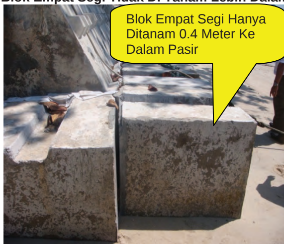
Foto 3.8 Blok Empat Segi Tidak Di Tanam Lebih Dalam
