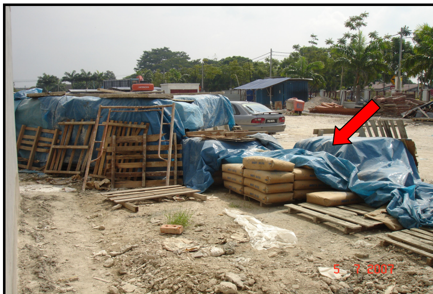
Foto 4 Simen Diletakkan Di Tempat Terbuka Di Atas Tanah Beralaskan Kayu
