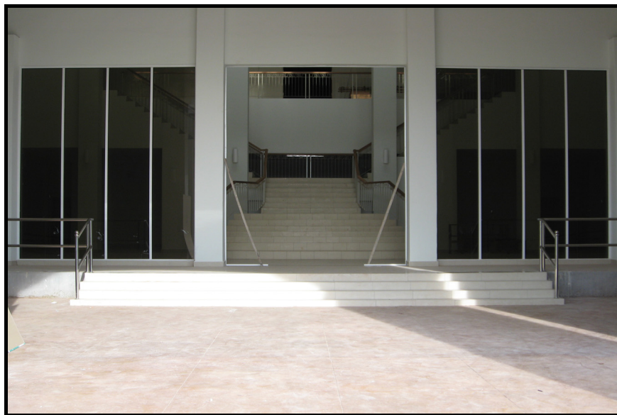
Foto 1 Kerja-Kerja Perubahan Pada Pintu Masuk Utama Yang Masih Tertangguh
