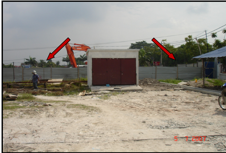
Foto 5 Dinding Pengadang Dibina Di Sekeliling Tapak Bina
