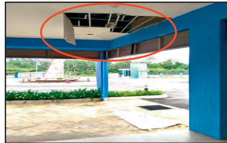
Lobi Utama Pejabat Cawangan Taman Laut, Tanjung Gemok, Pahang - Siling Runtuh Akibat Kesan Resapan Air dari Bumbung (07.03.2023) (Sumber: Cawangan Taman Laut Tanjung Gemok, Pahang)
