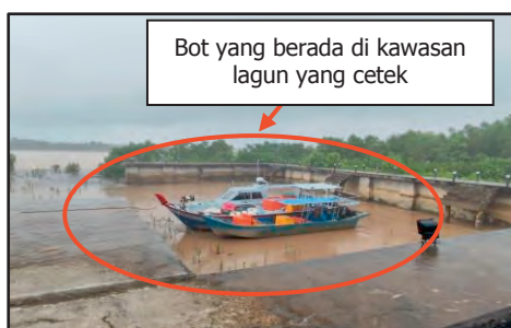
Pangkalan Hadapan Cawangan Taman Laut Tanjung Gemok, Pahang - Kedalaman di Jeti/Marina Yang Cetek Tidak Sesuai untuk Pergerakan Keluar Masuk Bot (01.03.2023) (Sumber: Jabatan Audit Negara)
