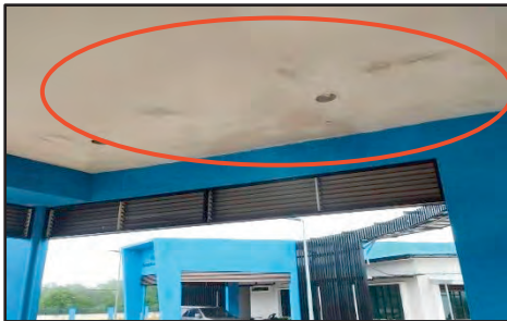
Lobi Utama Pejabat Cawangan Taman Laut, Tanjung Gemok, Pahang - Kesan Resapan Air pada Siling Bumbung (02.03.2023) (Sumber: Jabatan Audit Negara)
