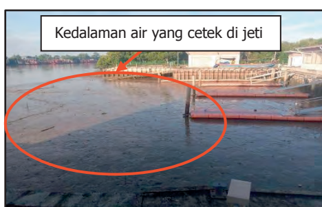
Pangkalan Hadapan Cawangan Taman Laut Kampung Kelunchor, Kedah - Masalah Air Cetek di Jeti/Marina Menyebabkan Bot Tidak Dapat Berlabuh (03.11.2022) (Sumber: Jabatan Audit Negara)
