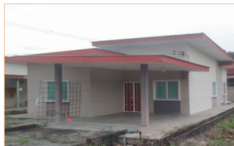
RMR Sungai Midin, Bahagian Kuching - Rumah Siap Dibina dan Diduduki (12.08.2022) (Sumber: Jabatan Audit Negara)
