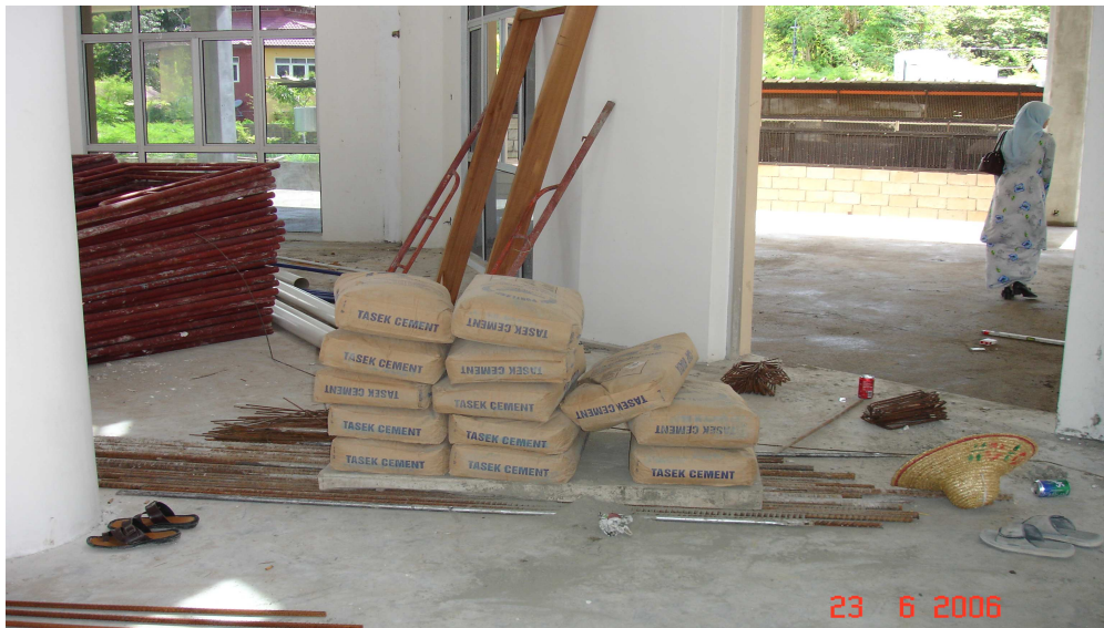
Foto 19 Bahan Binaan Diletakkan Dalam Bangunan Belum Siap Di Tapak Projek Masjid Ar-Rahmah Batu Ferringhi
