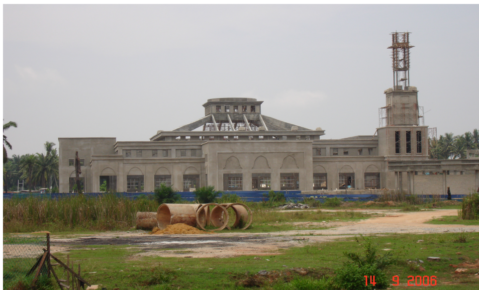
Foto 29 Masjid Transkrian Yang Masih Dalam Peringkat Pembinaan
