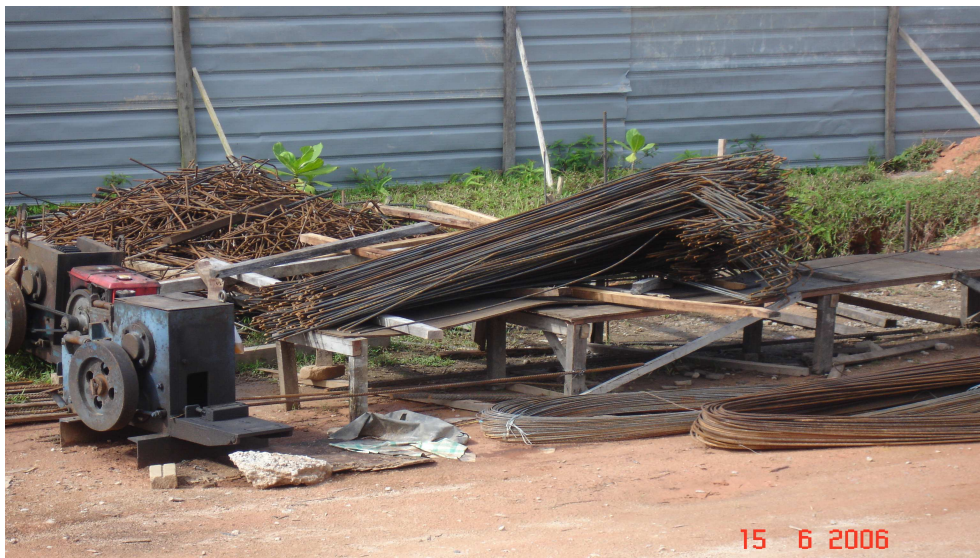
Foto 17 Mesin Untuk Membengkokkan Besi Di Projek Masjid Transkrian Diletakkan Di Kawasan Terbuka
