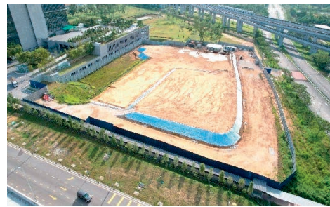
Plot C8, Kwasa Damansara (MBSA) - Kerja tanah sedang dilaksanakan bagi Fasa 2 pembinaan pusat perniagaan (23.05.2023) (Sumber: KLSB)
