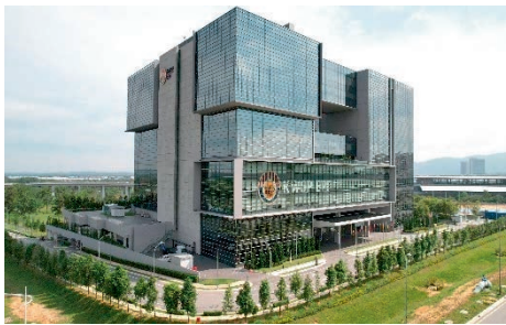
Plot C8, Kwasa Damansara (MBSA) - Bangunan KWSP telah siap dibina bagi Fasa 1 (23.05.2023) (Sumber: KLSB)
