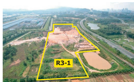
Plot R3-1, Kwasa Damansara (MBSA) - Kerja tanah sedang dijalankan (23.05.2023) (Sumber: KLSB)
