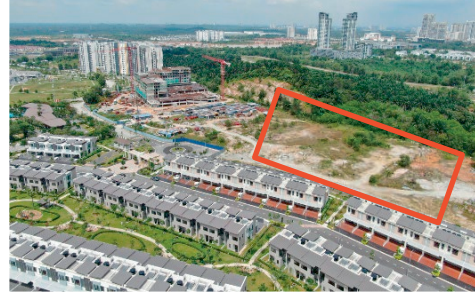
Projek Laman View, Cyberjaya - Tapak Fasa 4A belum dimulakan pembinaan (03.02.2023) (Sumber: CSB Land)
