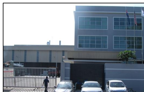
PTD 5020 (PLO 7), Jalan Rumbia 4, Kompleks Perindustrian Tanjung Langsat - Pegangan Belum Dinilai Selepas Perakuan CCC (17.04.2018)
