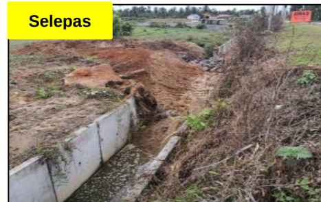
Jalan Semanyir (J73), Mersing - Kerja Pembaikan Sedang Dilaksanakan (10.10.2018) Sumber: JKR
