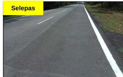
Jalan Desaru – Tanjung Balau (J226), Kota Tinggi - Kerosakan Jalan Telah Dibaiki (01.05.2018) Sumber: JKR
