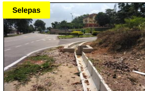
Jalan Lama Hospital, Segamat - Longkang Konkrit Telah Dibaik Pulih (26.09.2018) Sumber: JKR
