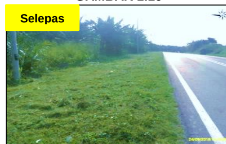
Jalan Bekoh (J123), Tangkak - Rumput Telah Dipotong (24.09.2018) Sumber: JKR
