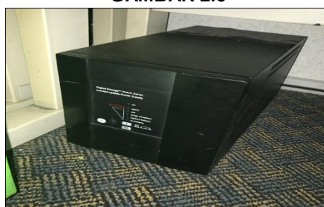
Bilik ICT, Majlis Daerah Tangkak - UPS Komputer Tidak Dilabelkan Hak Milik Kerajaan (27.09.2017)
