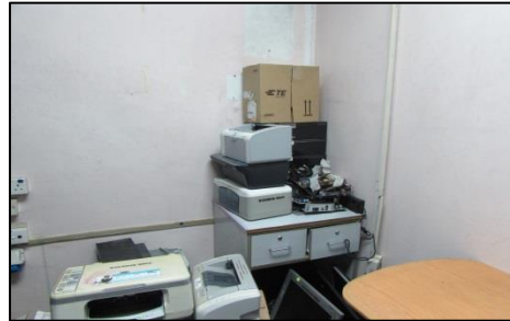
Bilik Server, Majlis Daerah Simpang Renggam - Mesin Printer Rosak dan Kotak Disimpan Dalam Bilik Server (21.02.2018)
