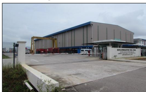
PLO 748 (Zone 12B), Jalan Platinum 3, Kawasan Perindustrian Pasir Gudang - Pegangan Belum Dinilai Selepas Perakuan CCC (17.04.2018)
