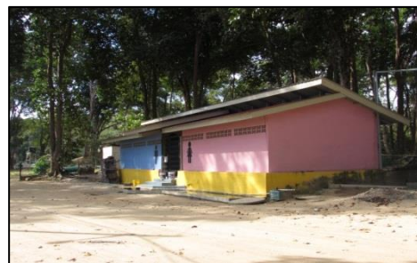
PTD 1673, Pantai Pasir Lanun, Penyabong - Tandas Berstruktur Kekal (27.03.2017)
