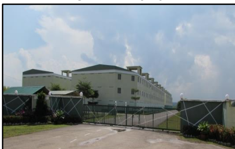
Bio Desaru Mukim Pantai Timur, Kota Tinggi - Fasa 1 Lot 1 yang Telah Siap Dibina (1.8.2017)
