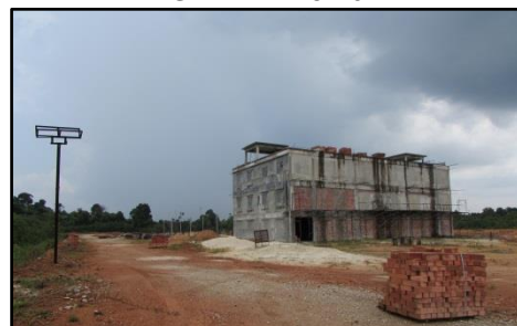
Bio Desaru Mukim Pantai Timur, Kota Tinggi - Fasa 1 Lot 2 yang Sedang Dibina (1.8.2017)
