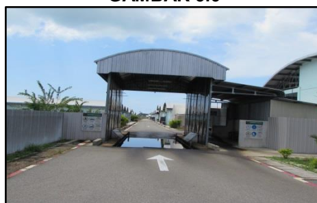
Bio Desaru Mukim Pantai Timur, Kota Tinggi - Pintu Masuk ke Bangunan Penetasan Udang Putih (23.5.2017)
