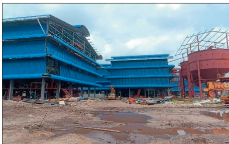
Tapak Kilang YPPH (Pekan) Oil Mill, di Gugusan Bebar/Pekan - Tapak Kilang YPPH (Pekan) Oil Mill yang Sedang Dalam Proses Pembinaan (08.08.2022) (Sumber: Jabatan Audit Negara)
