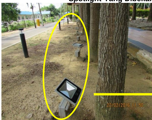
Gambar 5.4 Spotlight Yang Dibekalkan Tidak Mengikut Spesifikasi
