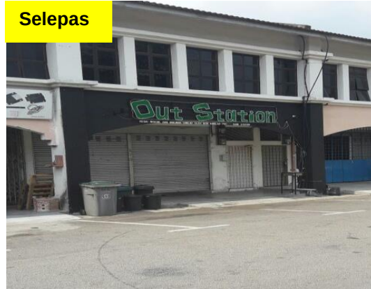
Gambar 4.20 Halangan Di Tempat Awam Telah Di Ambil Tindakan
