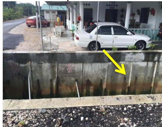
Gambar 2.6 Pemasangan Precast Drain Telah Diperkemas
