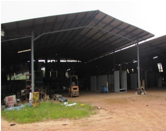
Gambar 1.45 Kilang Pemasangan Bingkai Tingkap Beroperasi Di Atas Tanah Kategori Pertanian
