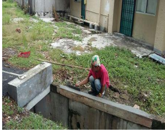
Gambar 2.17 Capping Beam Pecah Sedang Diperbaiki
