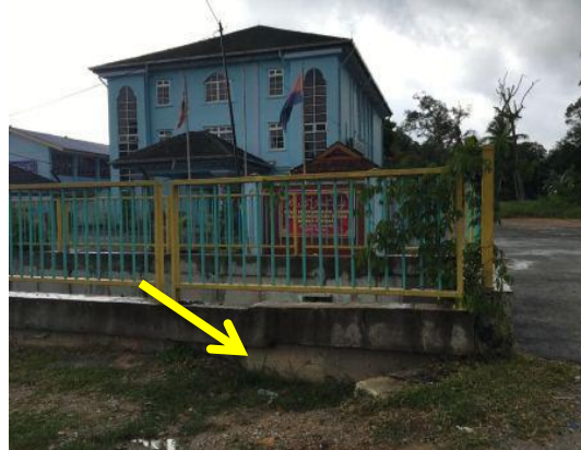
Gambar 2.4 Kedudukan Paras Tanah Lebih Rendah Dari Capping Beam
