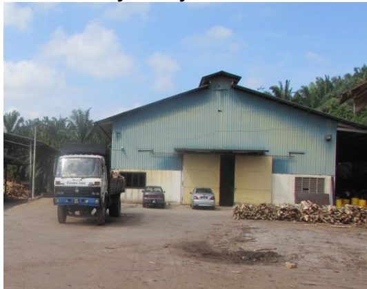
Gambar 1.55 Kilang Span Di Atas Tanah Syarat Nyata Tiada
