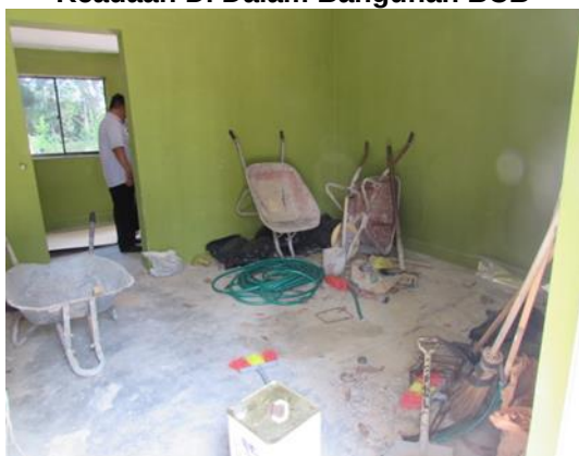
Gambar 5.25 Keadaan Di Dalam Bangunan BCB
