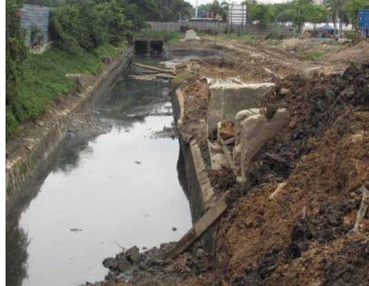
Gambar 2.24 Pemasangan Sebahagian Pagar Adang
