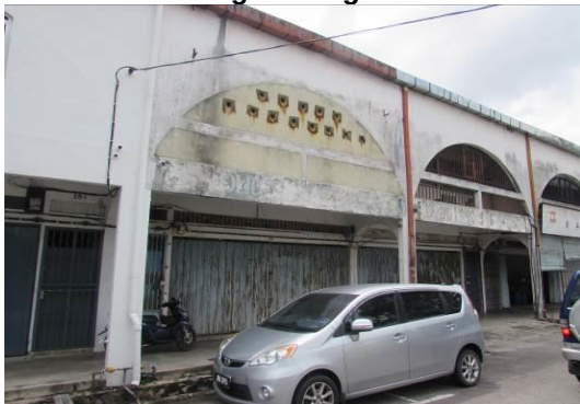
Gambar 4.24 Bangunan Rumah Kedai Dijadikan Sarang Burung Walit
