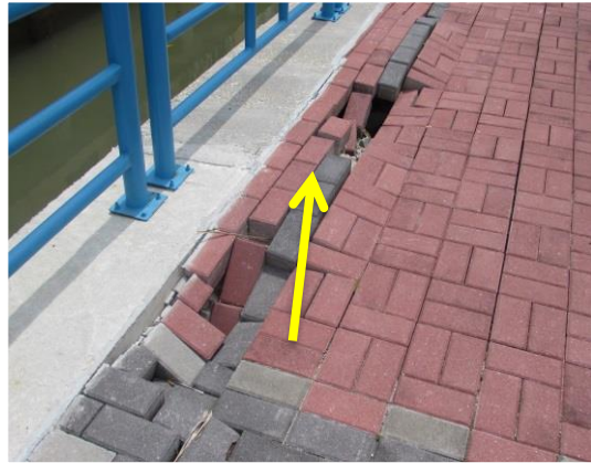
Gambar 2.19 Susunan Paver Block Berlubang
