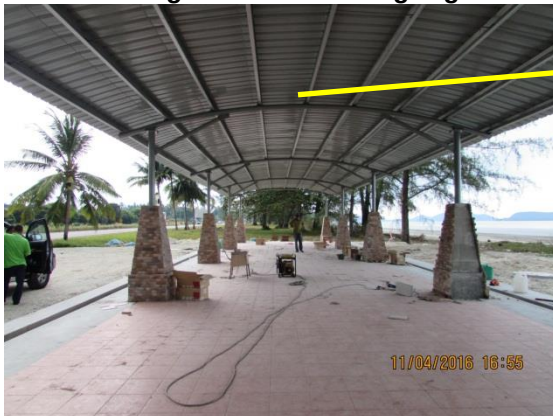
Gambar 5.10 Bumbung Metal Deck Yang Diganti
