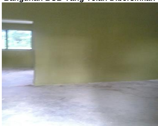
Gambar 5.26 Bangunan BCB Yang Telah Dibersihkan
