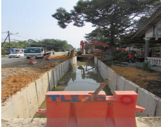
Gambar 2.23 Pagar Adang Tidak Dibina Di Kawasan Penempatan Penduduk dan Tepi Jalan raya
