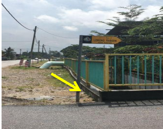
Gambar 2.3 Kedudukan Paras Tanah Lebih Rendah Dari Capping Beam
