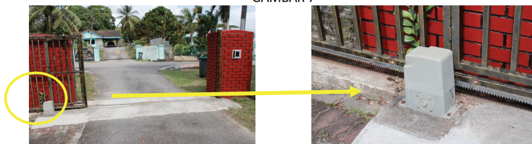
No. 192, Jalan Masjid, Mersing - Pembaikan Pagar (mengganti motor auto gate ) (Sumber: Baucar Bayaran JPS Mersing)
