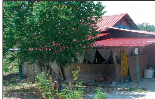
PTD 624 Mukim Kambau - Tanah Kerajaan yang Dijadikan Rumah Kediaman (14.06.2022) (Sumber: Jabatan Audit Negara)
