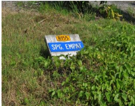
Gambar 1.13 Kilometer Post Yang Rosak Dan Tidak Dibaiki
