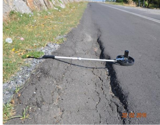
Gambar 1.22 Jalan Retak/Patah
