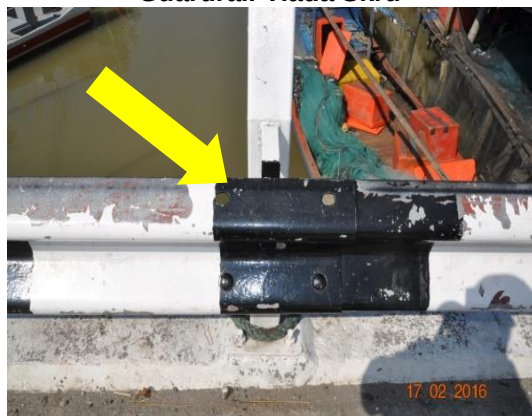
Gambar 1.19 Guardrail Tiada Skru
