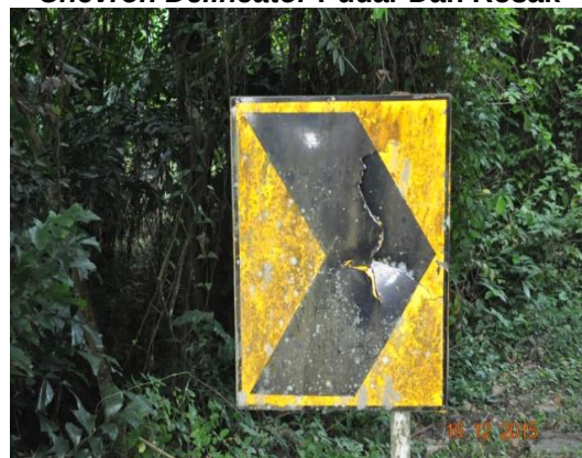
Gambar 1.9 Chevron Delineator Pudar Dan Rosak
