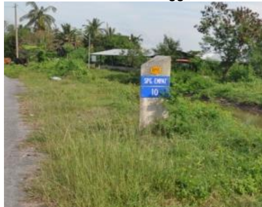
Gambar 1.14 Kilometer Post Yang Terlindung Dan Tidak Disenggara
