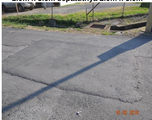
Gambar 1.34 Keluasan Premix Terkurang Bina 2.0m x 3.6m sepatutnya 2.0m x 5.0m
