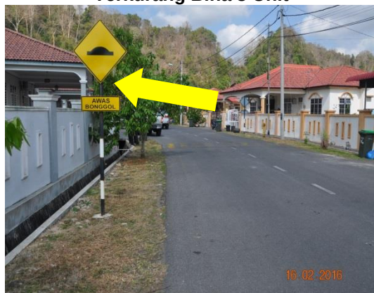
Gambar 1.32 Papan Tanda Bonggol Jalan Terkurang Bina 3 Unit
