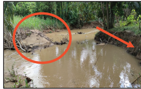
Sungai Dalit, Keningau - Tebing Runtuh Dan Pasir/Kayu Tidak Disenggara/Dibersihkan (14.06.2022) (Sumber: Jabatan Audit Negara)
