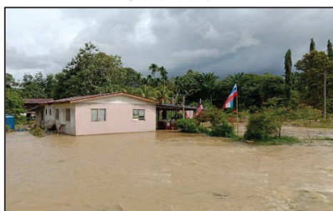
Kg. Kawang Lama, Sipitang - Kejadian Banjir Disebabkan Limpahan Air Sungai Mengalong/Lukutan (Sumber: DID)
