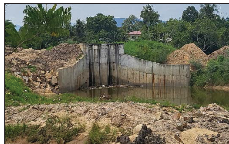
Pakej 3 Projek PLSB Sg. Moyog - Kerja Pembinaan Sedang Dilaksanakan (18.07.2022) (Sumber: Jabatan Audit Negara)
