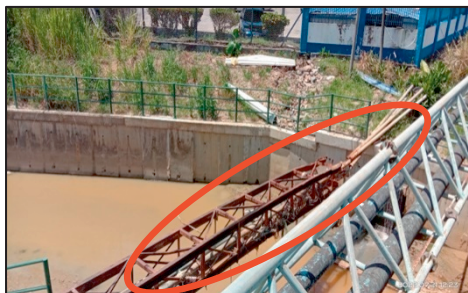
Projek RTB Sg. Gurong-Gurong, Lembangan Sg. Gurong-Gurong, Pekan Kota Belud - Isu Pemindahan Utiliti Telekom Belum Selesai (21.07.2022)
