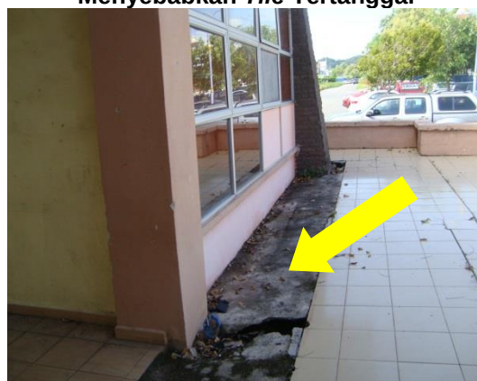
Gambar 2.5 Pemendapan Tanah Menyebabkan Tile Tertanggal
