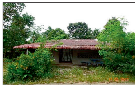
Tapak Bangunan Kediaman di Sungai Satan, Jeli - Tanah Telah Dibina Bangunan Kediaman dan Tidak Didiami (12.06.2022) (Sumber: Jabatan Audit Negara)
