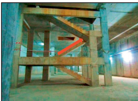
Infrastruktur Tangga Ke Stesen Monorel Yang Telah Dibina (16.08.2022) (Sumber: Jabatan Audit Negara)
