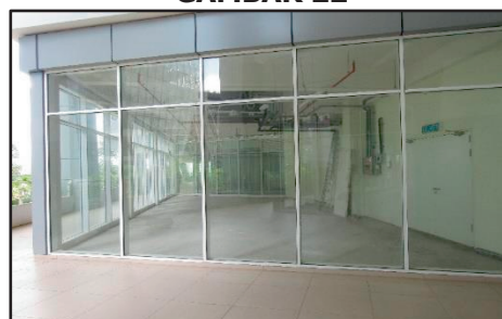
Suasana PjH, Presint 2 - Ruang Komersial yang Masih Belum Digunakan (07.06.2022) (Sumber: Jabatan Audit Negara)
