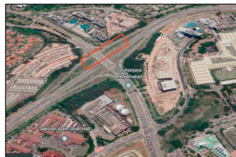
Lokasi Pembinaan Ramp/Flyover di Jalan P15H (16.08.2022) (Sumber: Jabatan Audit Negara)
