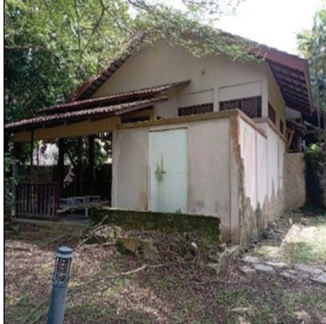
FR Hot Springs - Spa eksklusif usang dan tidak dapat digunakan (25.05.2022) (Sumber: Jabatan Audit Negara)
