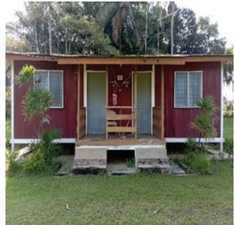
FR Tekam - Chalet 14 dan 16 tidak digunakan sejak tahun 2018 (07.06.2022) (Sumber: Jabatan Audit Negara)
