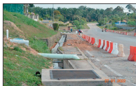
Jalan masuk Kem Segamat, Johor - Tapak Kerja Pelebaran Jalan AC/DC (27.01.2022) (Sumber: Jabatan Audit Negara)
