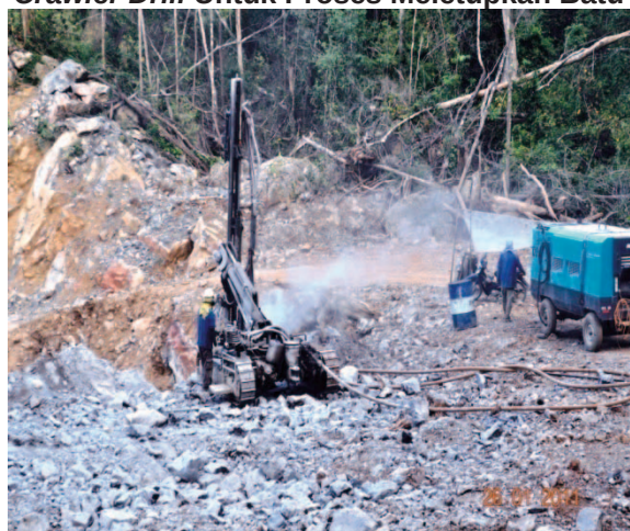
Gambar 8.4 Kerja-Kerja Penggerudian Menggunakan Crawler Drill Untuk Proses Meletupkan Batu
