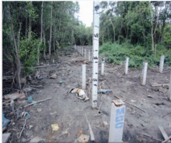
Gambar 6.6 Cerucuk Konkrit Yang Tenggelam Di Laluan Pejalan Kaki HPL Pulau Ketam
