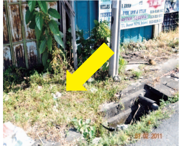
Gambar 3.4 No Akaun: 026869 Meter Tertimbus Dalam Tanah
