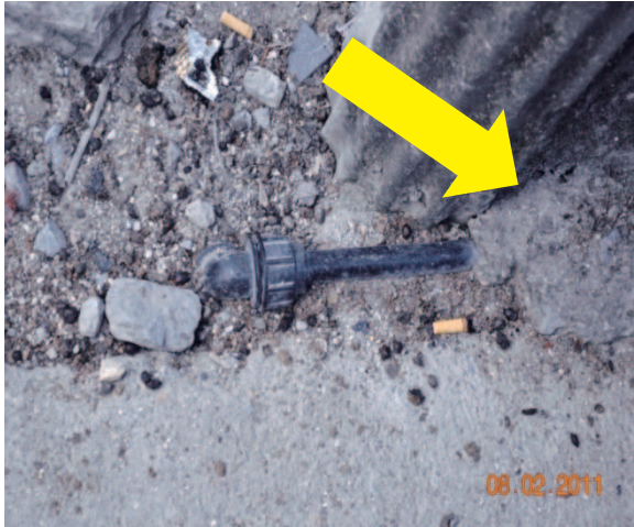
Gambar 3.3 No Akaun: 004512 Meter Tertimbus Dalam Simen
