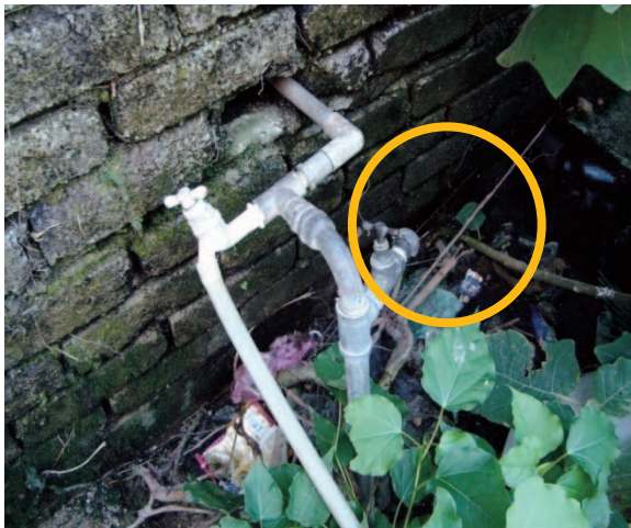
Gambar 3.5 No Akaun: 060591 Penyambungan Bekalan Air Secara Haram
