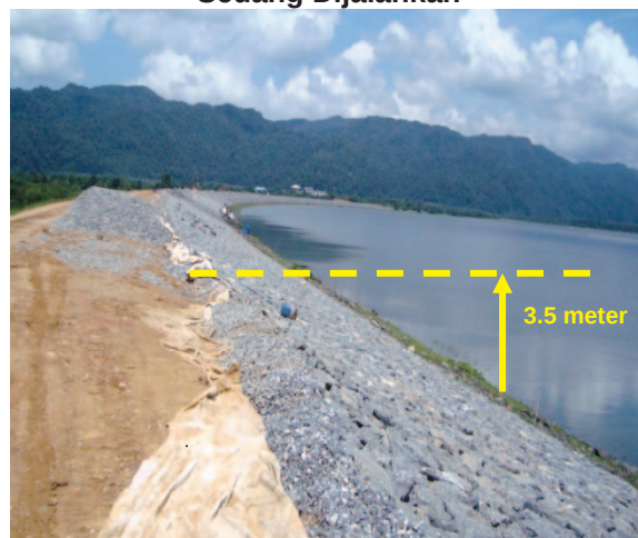
Gambar 4.3 Kerja-Kerja Meningkatkan Benteng Utama Sedang Dijalankan
