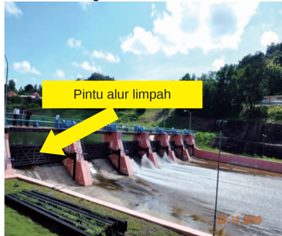
Gambar 4.4 Struktur Alur Limpah Sedia Ada Yang Belum Dinaik Taraf
