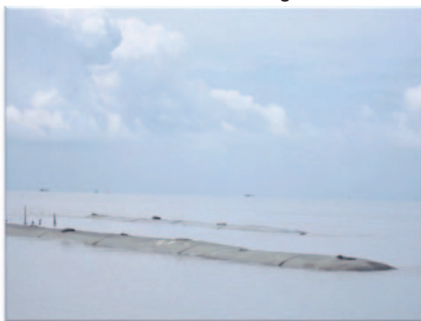
Gambar 6.5 Geotube Hampir Tenggelam Semasa Air Pasang
