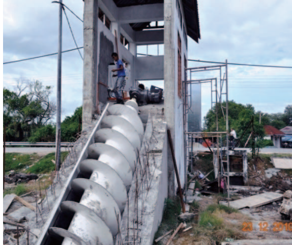
Gambar 4.17 Kerja-Kerja Pemasangan Pam Sedang Dijalankan
