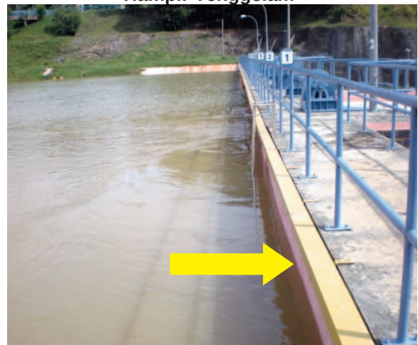
Gambar 4.6 Struktur Alur Limpah Hampir Tenggelam
