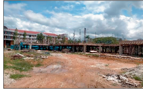
Projek Pembangunan Bercampur Jalan Maktab, Tanjung Malim - Fasa 1: Kedai Pejabat, Bazar dan Kompleks Sukan Masih Dalam Pembinaan (14.02.2022) (Sumber: Jabatan Audit Negara)
