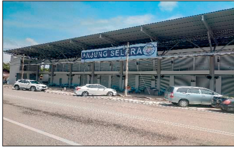
Projek Pembangunan Bercampur Jalan Maktab, Tanjung Malim - Fasa 1: Medan Selera Siap Dibina (14.02.2022) (Sumber: Jabatan Audit Negara)
