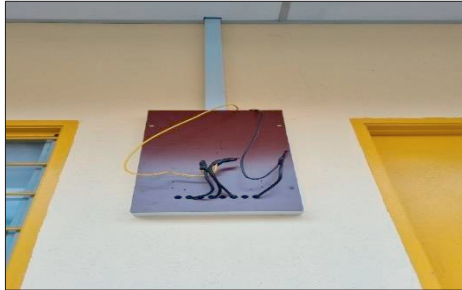
MTS D - Pengalihan Kotak Fius Utama Pendawaian Semula Belum Dipasang (15.02.2022) Sumber: Jabatan Audit Negara
