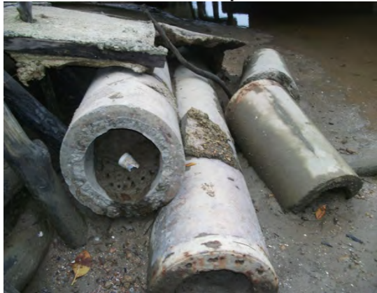
Gambar 5.27 Cerucuk Konkrit Yang Tidak Dibersihkan Dari Tapak Bina
