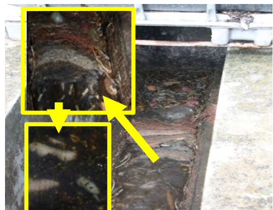
Gambar 9.8 Longkang Tersumbat Dan Berulat
