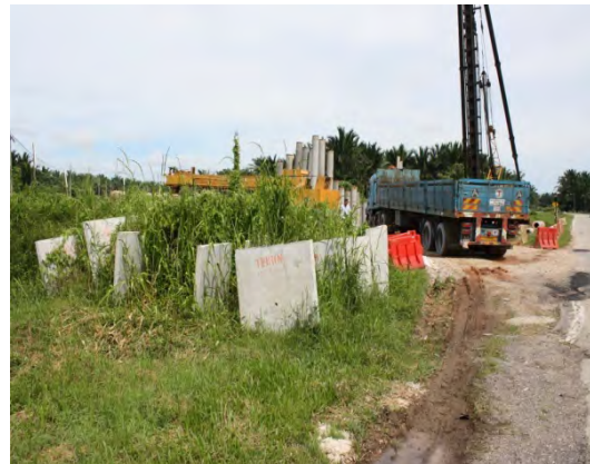
Gambar 5.3 Kerja Pembinaan Sedang Dijalankan
