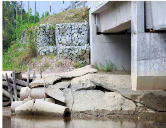
Gambar 5.28 Struktur Konkrit Yang Telah Pecah Dan Terbiar
