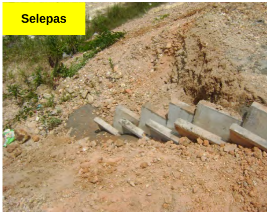
Gambar 5.18 Road Side Drain Telah Diperbaiki
