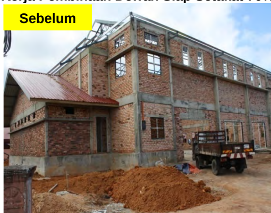
Gambar 2.4 Kerja Pmbinaan Dewan Siap Setakat 70%
