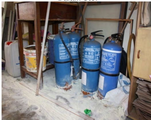
Gambar 6.26 Alat Pemadam Api Tamat Tempoh Diletak Dalam Stor
