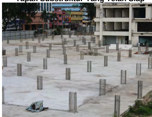
Gambar 13.2 Tapak Substruktur Yang Telah Siap
