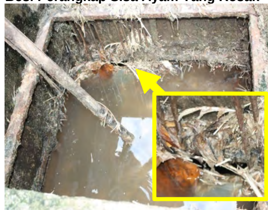
Gambar 9.4 Besi Perangkap Sisa Ayam Yang Rosak
