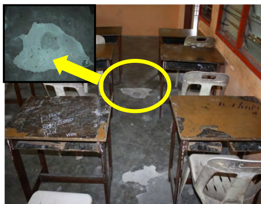
Gambar 6.9 Permukaan Lantai Bilik Darjah Dan Koridor Yang Berlubang-Lubang
