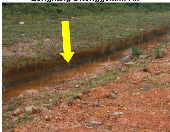
Gambar 5.16 Longkang Ditenggelami Air
