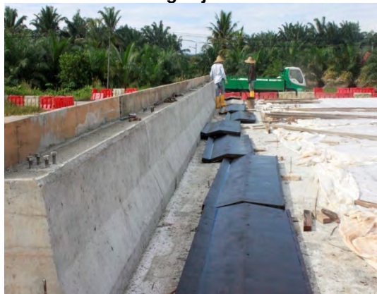
Gambar 5.2 Kerja Pembinaan Parapet Wall Jambatan Sedang Dijalankan
