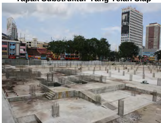
Gambar 13.1 Tapak Substruktur Yang Telah Siap
