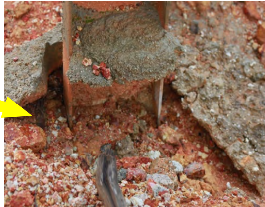
Gambar 5.19 Pemasangan Post Guard Rail Yang Tidak Sempurna
