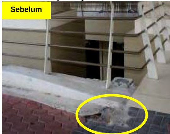
Gambar 3.13 Tanah Mendap Menyebabkan Simen Retak
