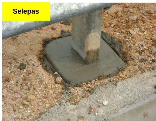
Gambar 5.20 Post Guard Rail Telah Diperbaiki
