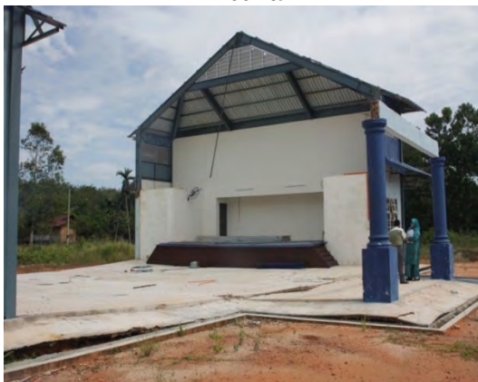
Gambar 2.1 Dinding Dewan Serba Guna Yang Telah Dibuka
