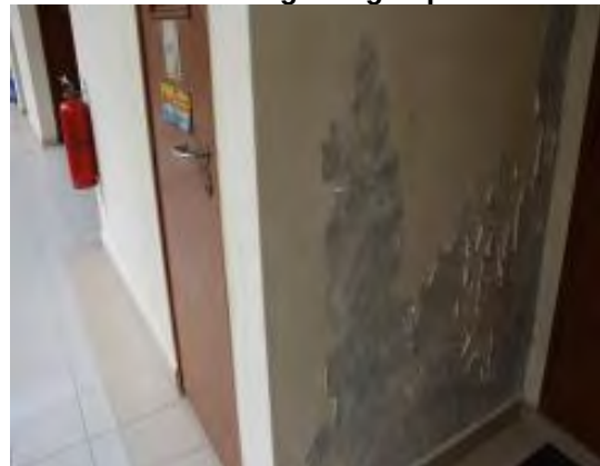
Gambar 3.6 Cat Dinding Mengelupas
