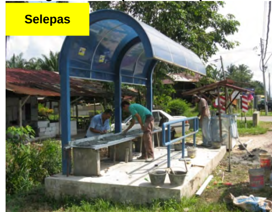
Gambar 5.35 Tempat Duduk Pondok Menunggu Bas Sedang Dibaiki Sepertimana Spesifikasi
