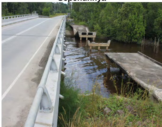
Gambar 5.25 Struktur Jambatan Lama Tidak Diroboh Sepenuhnya
