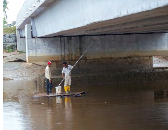
Gambar 5.30 Kerja Mengecat Semula Struktur Jambatan
