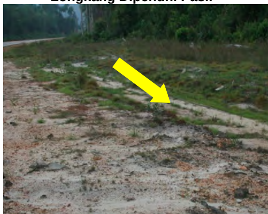
Gambar 5.17 Longkang Dipenuhi Pasir
