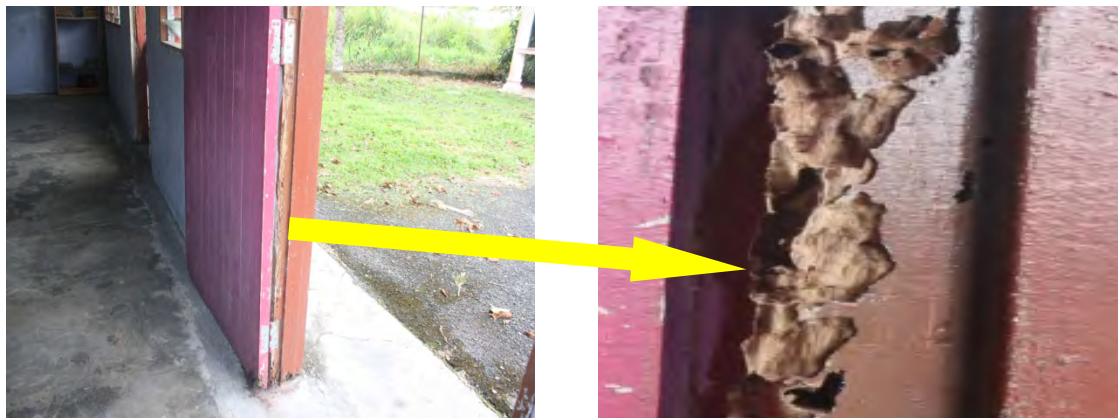
Gambar 6.7 Rangka Pintu Rosak Diserang Anai-Anai
