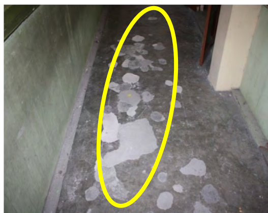
Gambar 6.9 Permukaan Lantai Bilik Darjah Dan Koridor Yang Berlubang-Lubang
