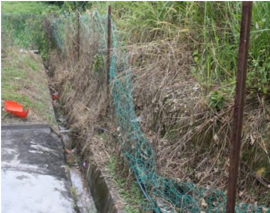
Gambar 6.20 Keadaan Pagar Yang Telah Roboh
