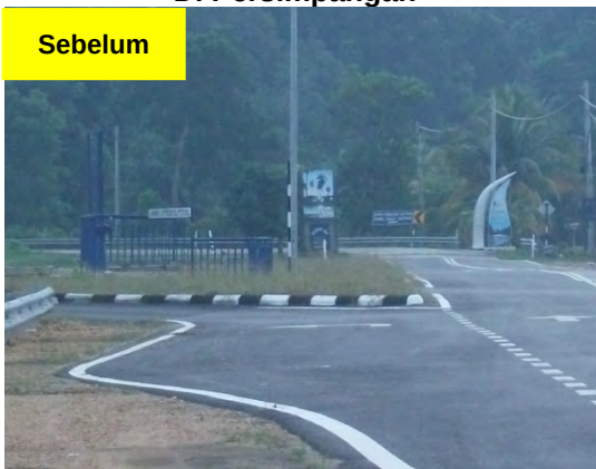
Gambar 5.9 Tiada Pemasangan WD36 Double Arrow Di Persimpangan
