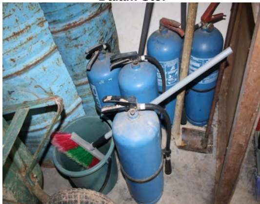
Gambar 6.25 Alat Pemadam Api Tamat Tempoh Diletak Dalam Stor
