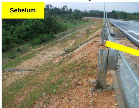
Gambar 5.19 Pemasangan Post Guard Rail Yang Tidak Sempurna
