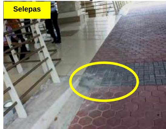
Gambar 3.14 Simen Retak Yang Telah Dibaiki
