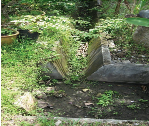
Foto 3.11 Longkang Kotor Dan Tersumbat (Kerja Pembersihan Longkang Sepatutnya Dibuat Pada 13 Hingga 14 Oktober 2009)
