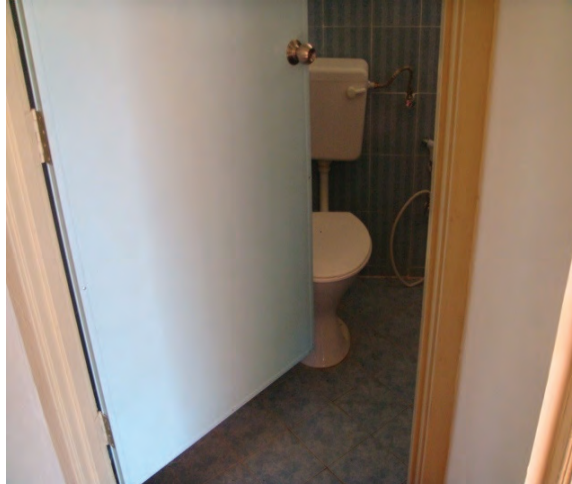
Foto 4.5 Daun Pintu Tandas Yang Tidak Dapat Dibuka Dengan Sempurna
