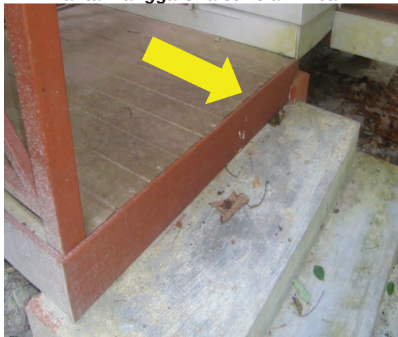
Foto 2.22 Lantai Tangga Chalet Telah Dibaiki
