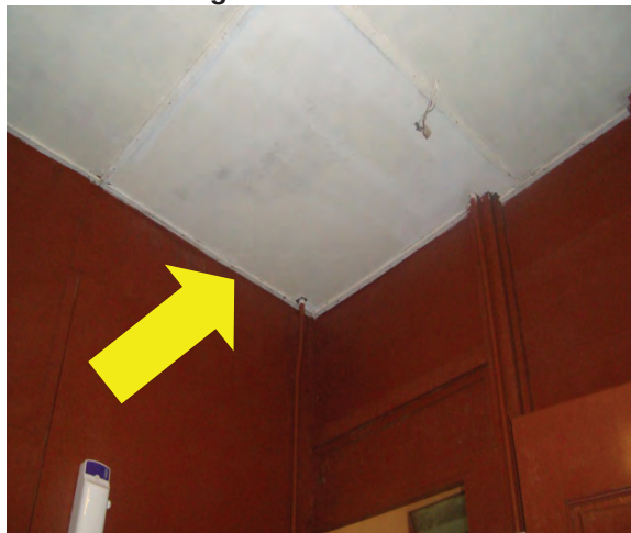
Foto 2.20 Siling Chalet Telah Dibaiki
