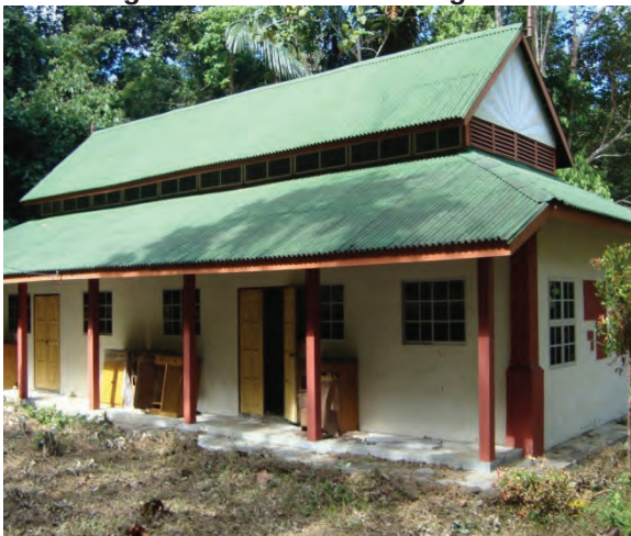
Foto 2.6 Bangunan Asrama Tidak Digunakan
