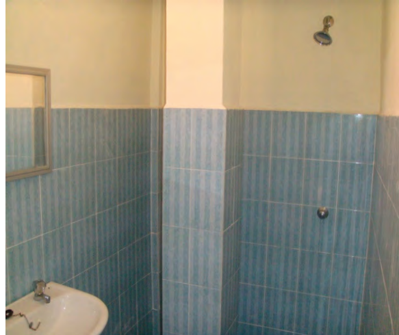
Foto 4.10 Kedudukan Tiang Dalam Bilik Air Tingkat Atas
