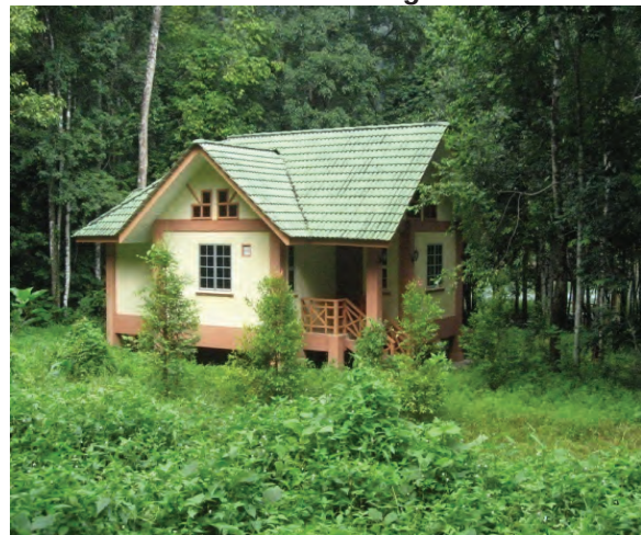
Foto 2.7 Rumah VIP Tidak Digunakan
