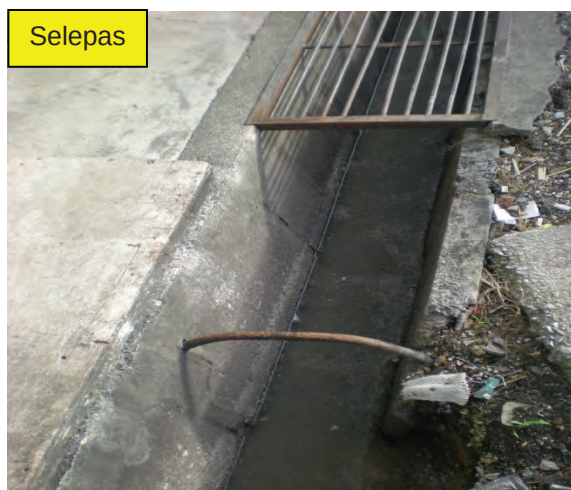
Foto 3.10 Longgang Telah Dibersihkan
