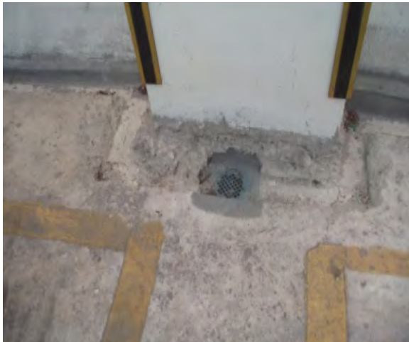
Gambar 11.8 Floor Trap, Longkang, Tiang Dan Permukaan Tidak Kemas
