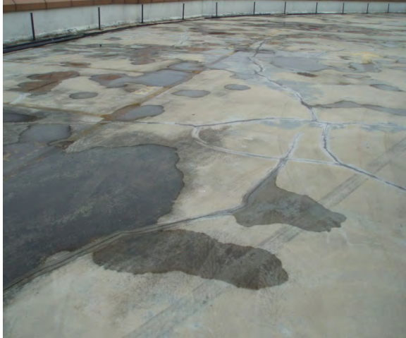
Gambar 11.2 Permukaan Bumbung Retak
