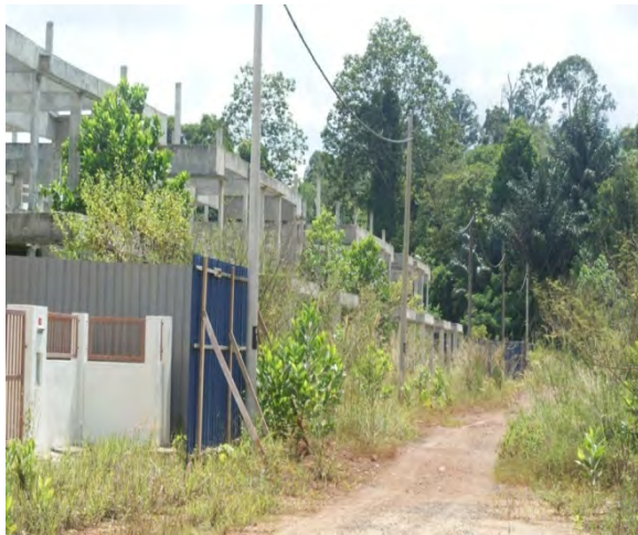
Gambar 3.19 Pembinaan Rumah Yang Terbengkalai Di Atas Tanah Milik SSI
