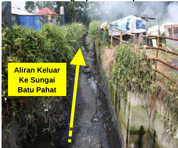
Gambar 6.5 Parit Yang Dipenuhi Lumpur
