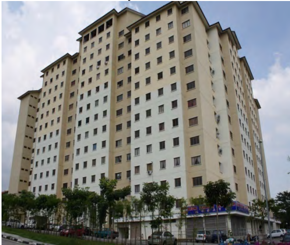
Gambar 3.3 Projek Pembangunan Setinggi Telah Siap Dan Diduduki
