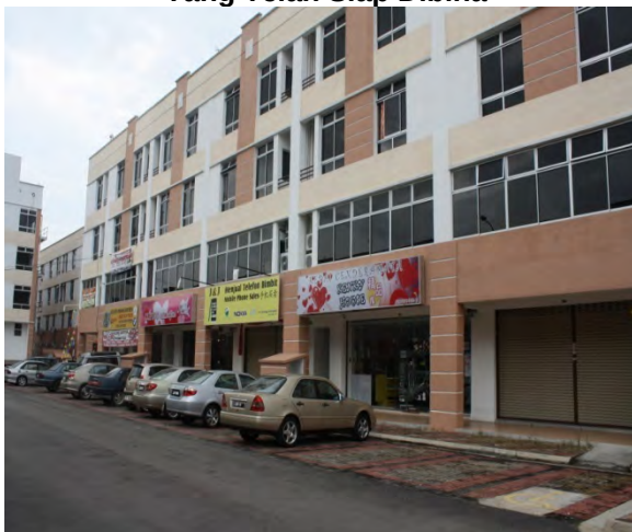
Gambar 3.9 Bangunan Kedai, Pejabat Dan Apartmen Yang Telah Siap Dibina
