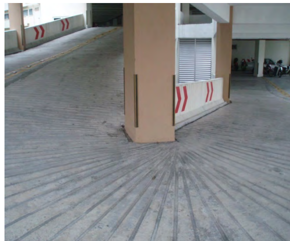
Gambar 11.17 Keadaan Selekoh Radius Pusingan Ramp
