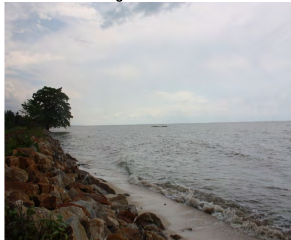
Gambar 2.8 Benteng Batu Yang Dibina JPS Bagi Mengawal Hakisan
