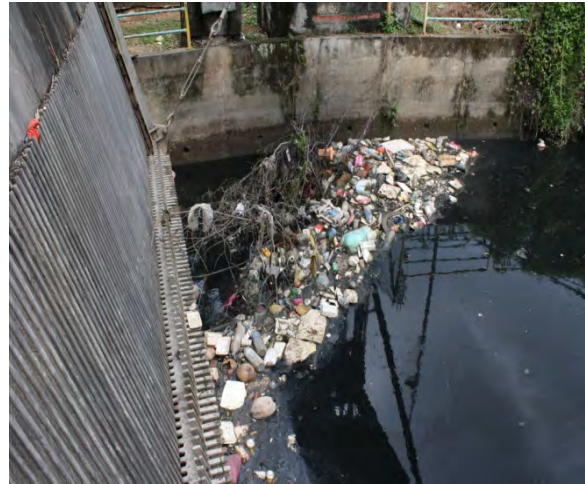
Gambar 6.12 Sampah Sarap Yang Diperangkap Oleh Automatic Trash Rake
