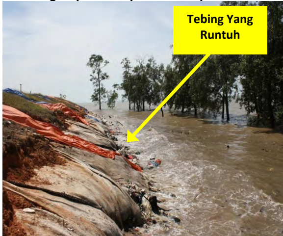
Gambar 2.19 Tebing Tapak Pelupusan Sampah Runtuh
