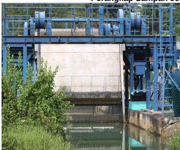
Perangkap Sampah Jenis Automatic Trash Rake
