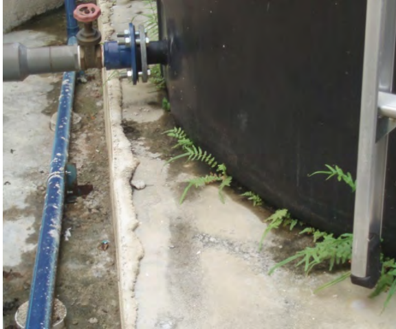
Gambar 11.4 Lepaan Simen Retak Dan Pecah
