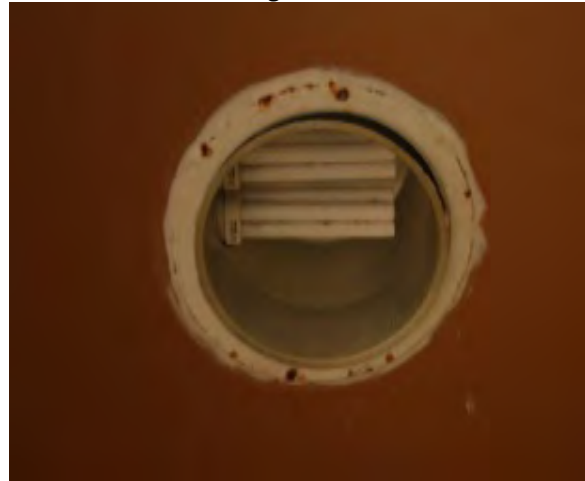
Gambar 11.7 Bocor Di Bahagian Lampu, Lampu Rosak Dan Casing Berkarat
