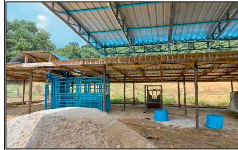
Jeram Pasu, Pasir Puteh - Kandang yang Telah Diubah Suai (09.02.2022) (Sumber: Jabatan Audit Negara)
