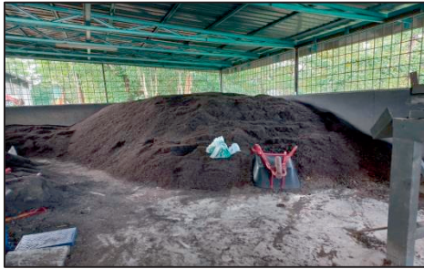
Labok, Machang - Stockpile Baja (09.02.2022) (Sumber: Jabatan Audit Negara)
