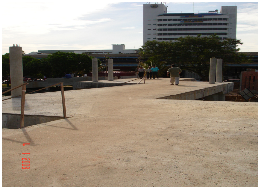
Foto 10 Jambatan Zig-Zag Sedang Dalam Pembinaan
