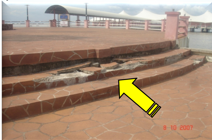
Foto 47 Mendapan Tanah Berlaku Di Bawah Paver Menyebabkan Paver Terbenam Ke Bawah Dan Rosak Di Dataran Bendera
