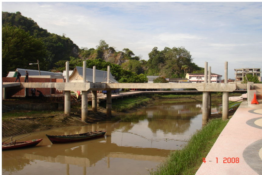
Foto 2 Jambatan Zig-Zag Yang Sedang Dibina
