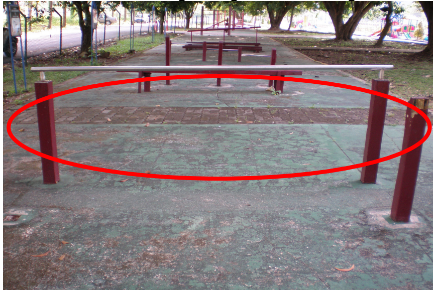
Foto 13 Alat Jalan Tangan Yang Rosak Dan Hilang
