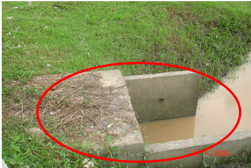
Foto 4 Penyambungan Box Culvert
