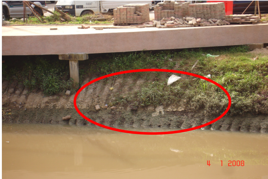
Foto 8 Tebing Sungai Yang Tidak Ditumbuhi Rumput Menggunakan Kaedah Sand Fill Mattress
