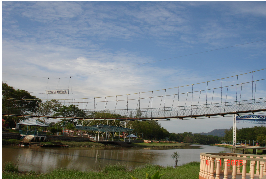
Foto 1 Jambatan Gantung Yang Telah Dibina
