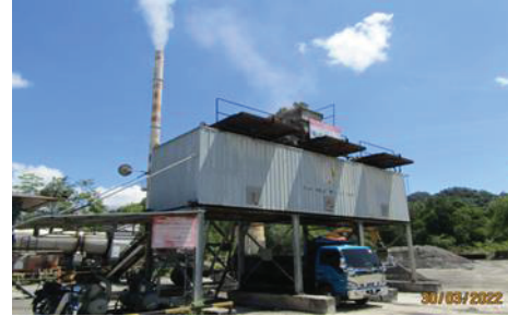
Loji Asfalt PISB - Stationery Drum Mix Asphalt berfungsi dengan baik (30.03.2022) (Sumber: Jabatan Audit Negara)
