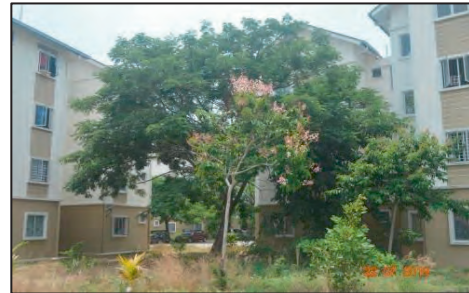
RPMM Pulau Duyong II, Kuala Terengganu - Pokok Tidak Ditebang (15.07.2019) (Sumber: Jabatan Audit Negara)
