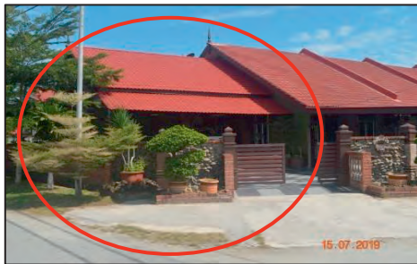
RMM Batu Hampar II, Kuala Terengganu - Rumah Telah Diubahsuai (15.07.2019) (Sumber: Jabatan Audit Negara)
