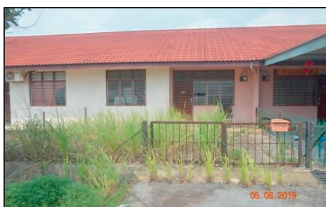
RMM Perasing Jaya, Kemaman - Rumah Tidak Diduduki (05.08.2019) (Sumber: Jabatan Audit Negara)
