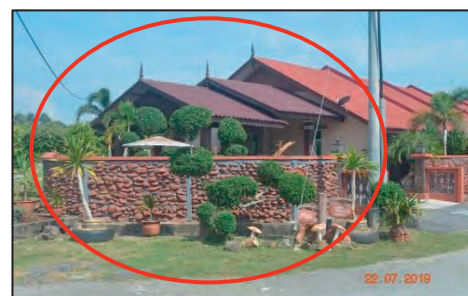
RMM Batu Hampar II, Kuala Terengganu - Rumah Telah Diubahsuai (22.07.2019) (Sumber: Jabatan Audit Negara)
