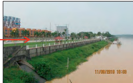
Zon D, Lembah Sireh - Pembinaan Retaining Wall (11.09.2019) (Sumber: Jabatan Audit Negara)
