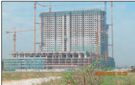
Perumahan PPA1M, Lembah Sireh -Pembangunan di Zon D (08.08.2019) (Sumber: Jabatan Audit Negara)
