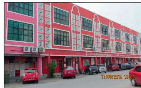
Lincoln University, Lembah Sireh -Pembangunan di Zon D (11.09.2019) (Sumber: Jabatan Audit Negara)
