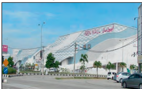
AEON Shopping Centre, Lembah Sireh - Pembangunan di Zon D (08.08.2019) (Sumber: Jabatan Audit Negara)
