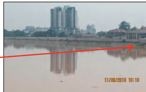
Zon B, Tebing Sungai Kelantan - Pembinaan Retaining Wall (11.09.2019) (Sumber: Jabatan Audit Negara)
