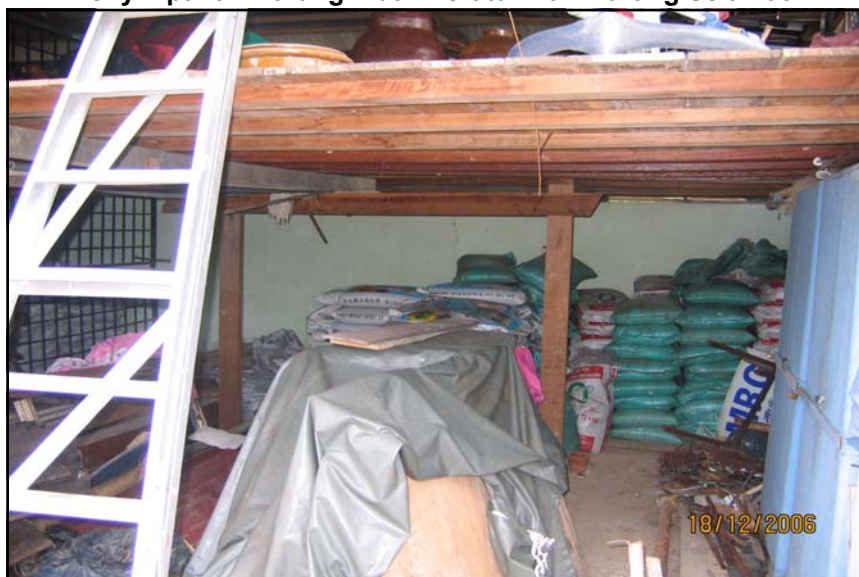
Foto 39 Penyimpanan Barang Tidak Teratur Dan Kurang Selamat
