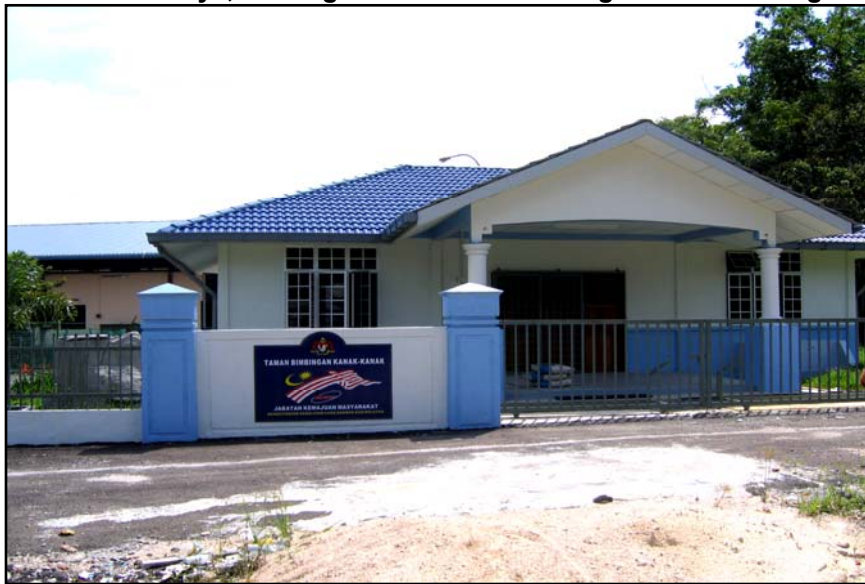
Foto 8 Pembangunan Tidak Mengikut Tujuan Asal Pengambilan Tanah Untuk Balai Raya, Padang Permainan Dan Bengkel Industri Ringan
