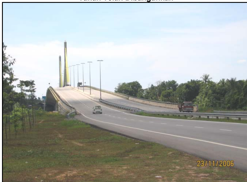
Foto 1 Tanah Telah Dibangunkan
