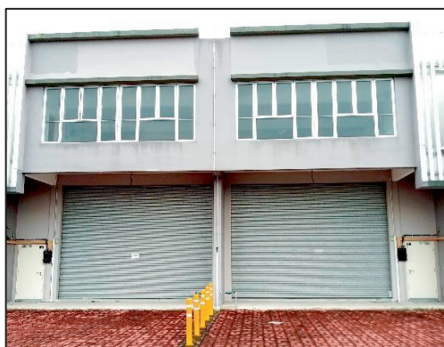
Kompleks Usahawan IKS Pasir Gudang -Kilang IKS Belum Disewakan - (No. PLO 829X & 829Y) (22.03.2022)
