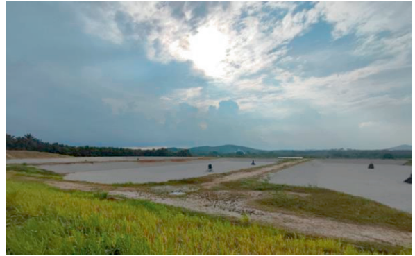
LRA Sungai Linggi Fasiliti Enap Cemar (21 Januari 2022) (Sumber: Jabatan Audit Negara)
