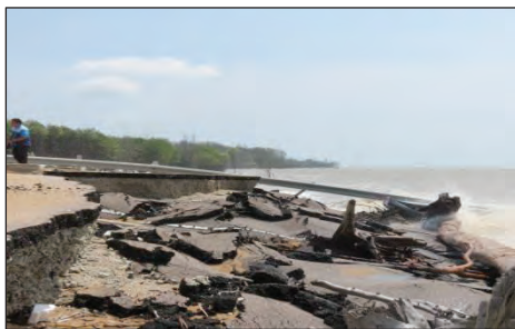
Kawasan Pembangunan TAMP - Keadaan Jalan Raya yang Runtuh Akibat Hakisan Pantai (18.07.2019) (Sumber: Jabatan Audit Negara)
