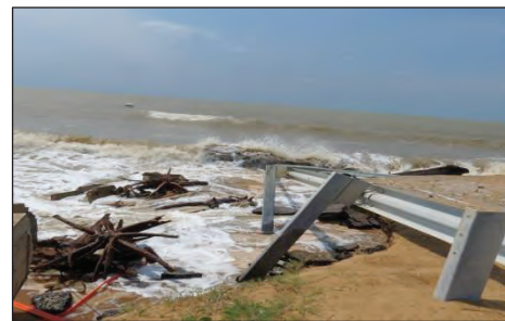
Kawasan Pembangunan TAMP - Keadaan Jalan Raya yang Runtuh Akibat Hakisan Pantai (18.07.2019) (Sumber: Jabatan Audit Negara)
