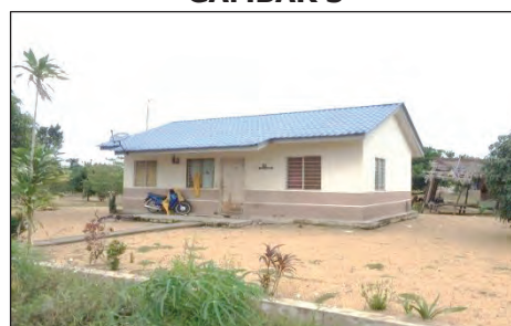
Kawasan Pembangunan TAMP - Penempatan Baru Rumah Orang Asli (18.07.2019) (Sumber: Jabatan Audit Negara)
