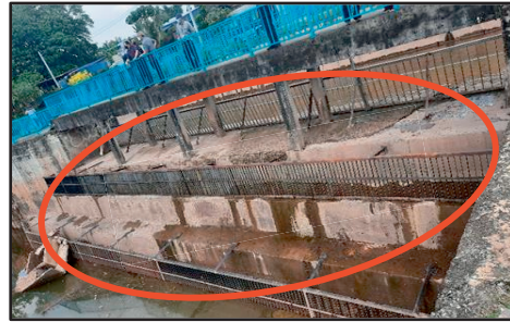
Kolam Takungan Air Leleh - Kawasan Zon Salur Masuk yang Hanya Ada Struktur Salur Masuk dan Perangkap Sampah. Tiada Perangkap Sedimen dan Tanjakan Penyenggaraan (15.03.2022) (Sumber: Jabatan Audit Negara)
