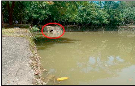
Kolam Lorong Maarof - Struktur Salur Masuk Tanpa Perangkap Sampah atau Sedimen (28.02.2022) (Sumber: Jabatan Audit Negara)
