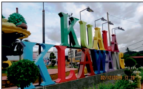
Pekan Kuala Klawang, Jelevu - Projek Membina Monumen Perkataan Nama Pekan Utama (02.12.2019) (Sumber: Jabatan Audit Negara)
