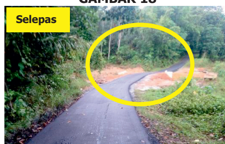
Kg. Sungai Pisang, Padang Terap - Culvert dan Jalan Telah Dibaiki (17.11.2020) (Sumber: PDT Padang Terap)
