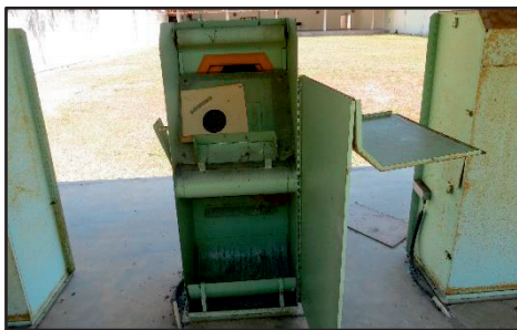
Lapang Sasar Menembak, Pokok Sena - Mechanical Marker Tidak Berfungsi bagi Lapangan Sasar Menembak 50 Meter (03.03.2020) (Sumber: Jabatan Audit Negara)
