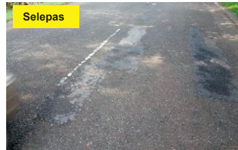
Jalan Kg. Bukit Kecil (K103) - Pembaikan Telah Siap Dijalankan (10.9.2020) (Sumber: JKR Daerah Kubang Pasu)
