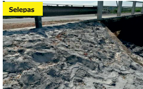
K104 - Kg. Bukit - Tebing Runtuh Telah Diambil Tindakan Pembaikan (6.12.2020) (Sumber: JKR Daerah Kubang Pasu)
