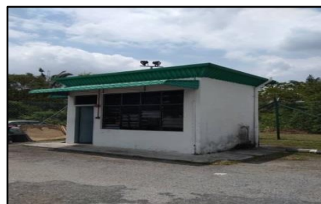
Pondok Pengawal - Kerja Mengecat Tidak Dilaksanakan (03.03.2020) (Sumber: Jabatan Audit Negara)
