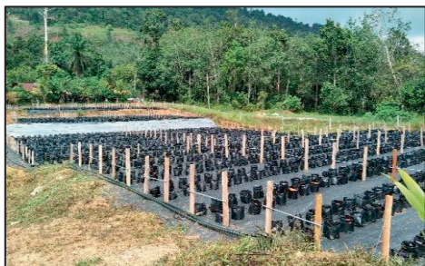
Projek Fertigasi Terung Usahawan PPK Maran, Pahang - Projek di Peringkat Pemasangan Peralatan (28.10.2021) (Sumber: Jabatan Audit Negara)
